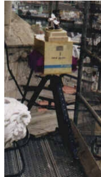
Laserscanner der Fa. Octocom am Wr. Stephansdom - Südturmgerüst
